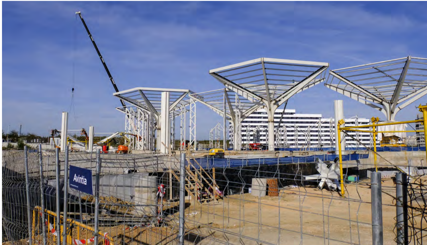
Obras de construcción del intercambiador de Valdebebas. SANDRA BLANCO
