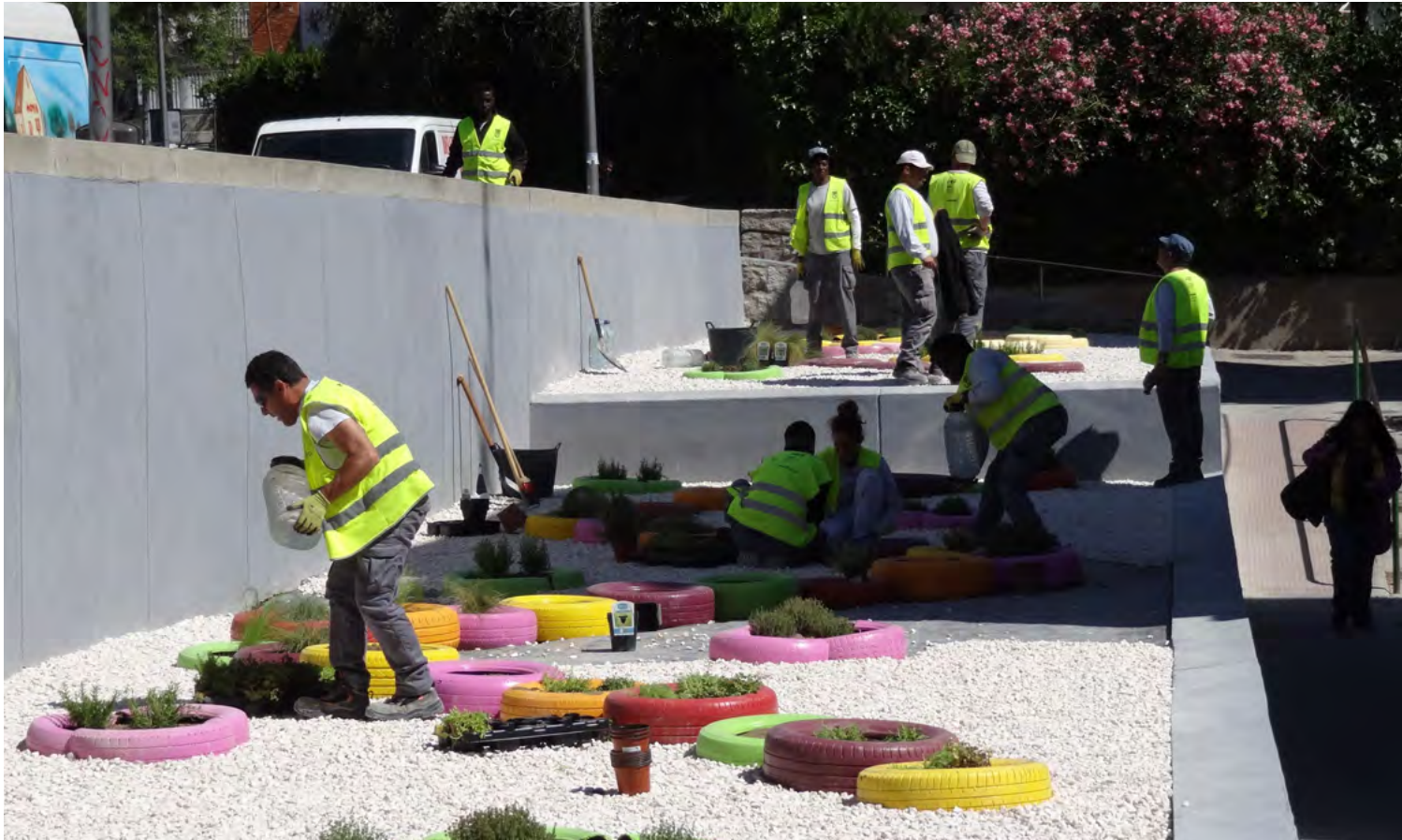
Miembros del Equipo de Actuación Distrital de Hortaleza, realizando trabajos de pintura, albañilería y jardinería en la calle Gomeznarro. ÁNGEL SÁNCHEZ
