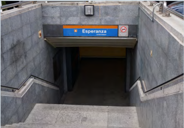
Acceso a la estación de Esperanza, que cerrará para ser reformada y eliminar el amianto de su bóveda. ÁNGEL SÁNCHEZ
